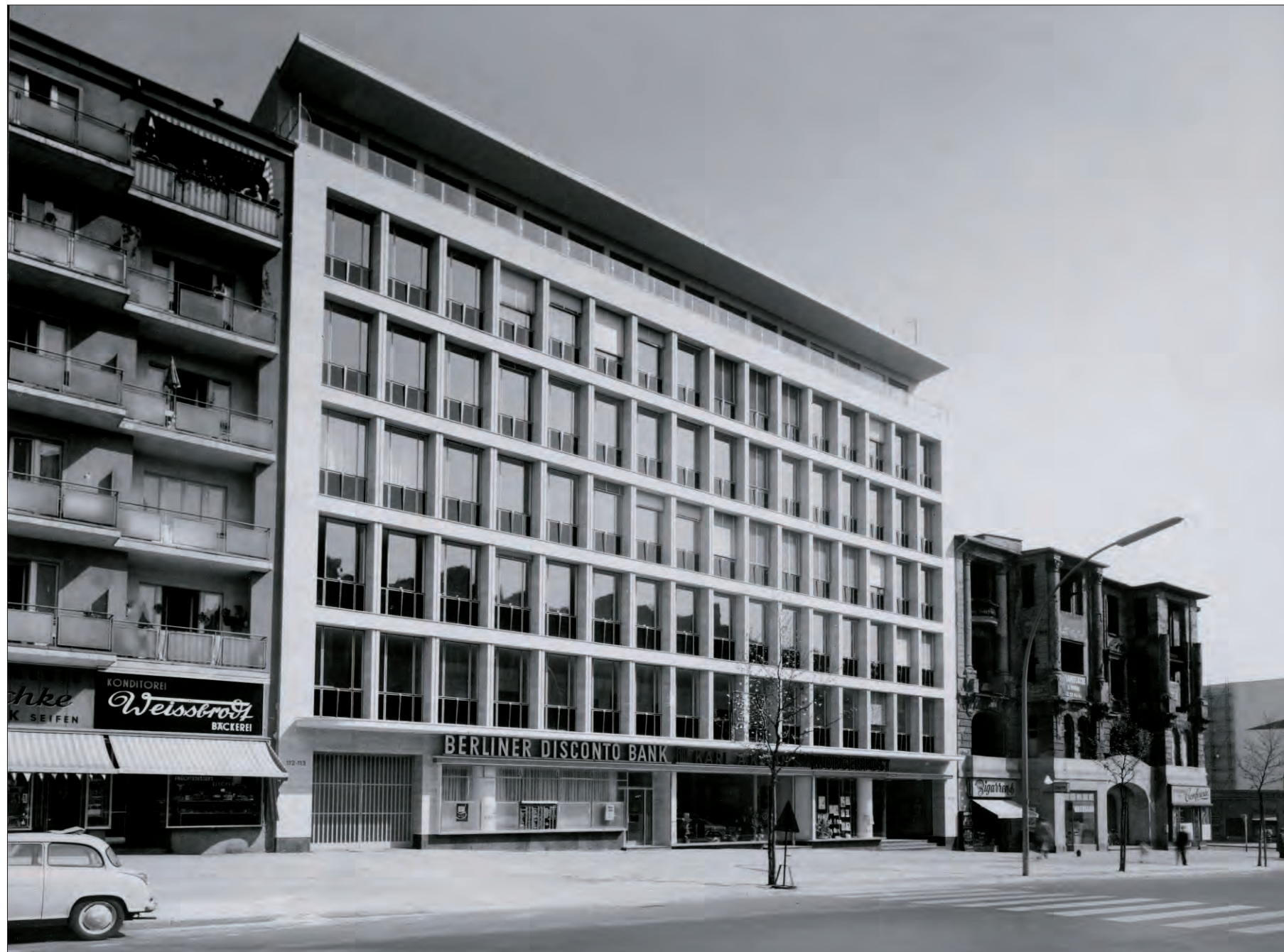
Das Verwaltungsgebäude des BVV am Kurfürstendamm im Jahr 1964
